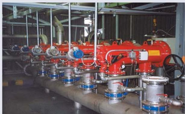
▲ Основная вода системы охлаждения, 680м<sup>3</sup>/ч, 100мкм. Производство пластиковых профилей. Тройсдорф, Германия
