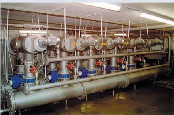
▲ Водозабор, 1000м<sup>3</sup>/ч, 50мкм. Халлертау, Германия
