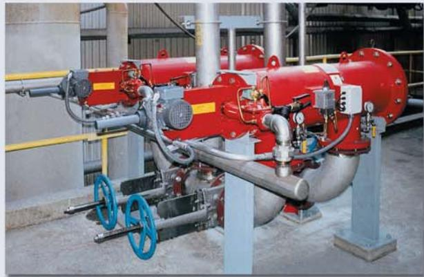
▲ Технологическая вода, 200м<sup>3</sup>/ч, 25мкм. Производство бумаги. Вашингтон, США
