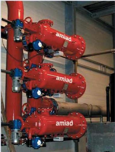
▲ Пре-фильтрация перед станцией водоочистки, 600м<sup>3</sup>/ч, 200мкм.
