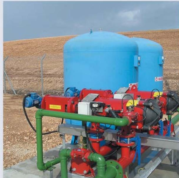
▲ Полив торфа, 90м<sup>3</sup>/ч, 100мкм. Станция водоочистки Нахария,
