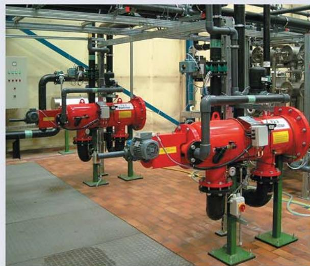
▲ Пре-фильтрация перед обратным осмосом, 45м<sup>3</sup>/ч, 10мкм.
