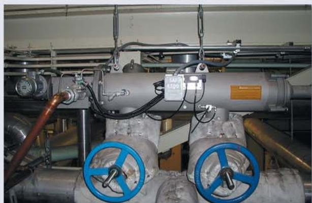
▲ Обработка красок, 45м<sup>3</sup>/ч, 10мкм. Производство самолетов. Сиэттл, США
