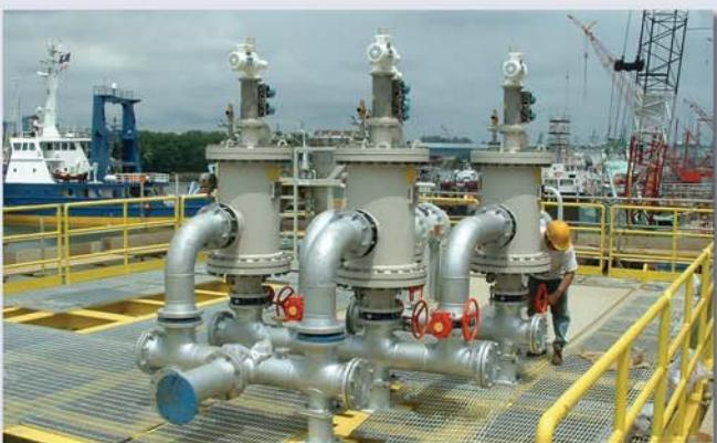
▲ Морская вода: фильтрация воды для впрыска 220 м<sup>3</sup>/ч, 200 мкм и 25 мкм. На борту морской платформы.
