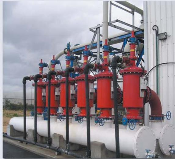
▲ Предварительная фильтрация перед мембранными обратного осмоса. 1700 м<sup>3</sup>/ч, 25 мкм. Установка обессоливания воды, Израиль
