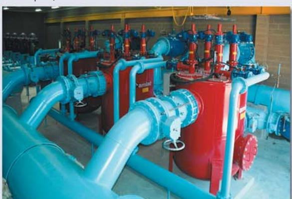
▲ Подача воды для отдыха и орошения. 3 400 м<sup>3</sup>/ч, 80 мкм. Спениш Форк, США
