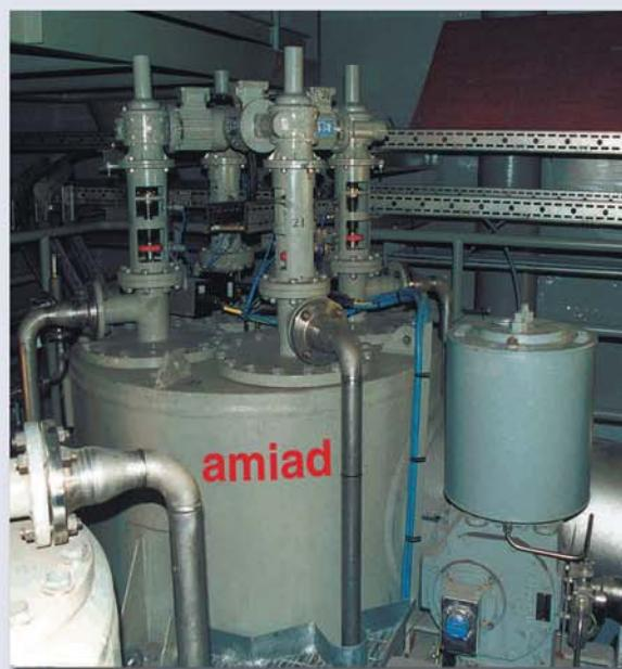
▲ Вода для впрыскивания. 2000 м<sup>3</sup>/ч, 50 мкм. Платформа в Северном море
