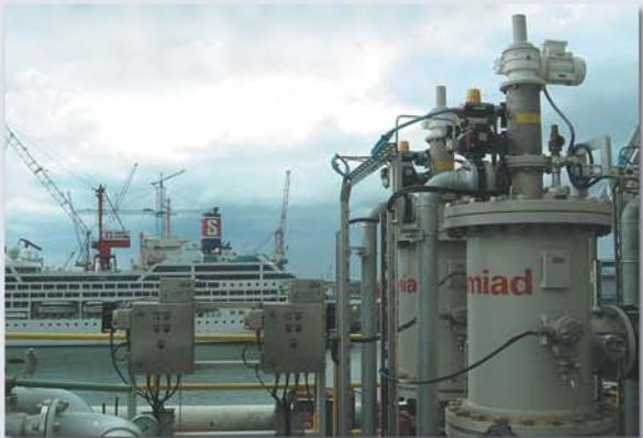
▲ Вода для впрыскивания на борту плавучей буровой станции. 220 м<sup>3</sup>/ч, 25 мкм. Западная Африка
