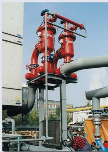
▲ Вода для охлаждения на химическом заводе. 460 м<sup>3</sup>/ч, 130 мкм. Гамбург, Германия
