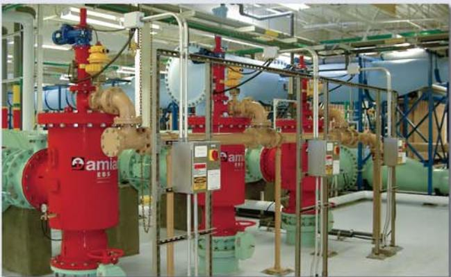
▲ Пре-фильтрация перед установкой микрофильтрации: 3 000 м<sup>3</sup>/ч, 300 мкм. Осветленная речная вода. Олейт (штат Канзас), США
