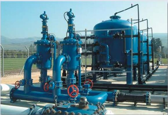
▲ Предварительная фильтрация перед станцией очистки воды. 375 м<sup>3</sup>/ч, 50 мкм. Река Дан, Израиль
